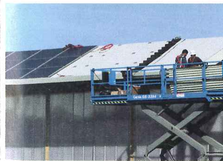
Pose des panneaux photovoltaïques sur l'avant: 132 modules polycristallins de 1,60 m 2 pour une surface totale de 211 m 2 .
